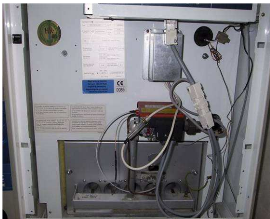
Figuur 7.15: premixbrander van een atmosferische gasgestookte verwarmingsketel type B 11
