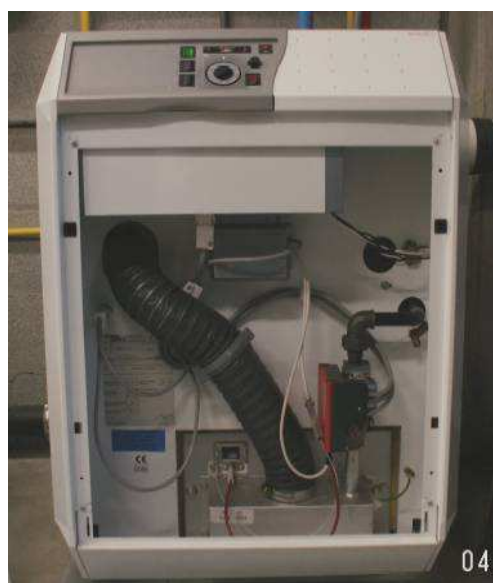
Figuur 7.20: gasgestookte verwarmingsketel HR+ met gedwongen rookafvoer (type C)
