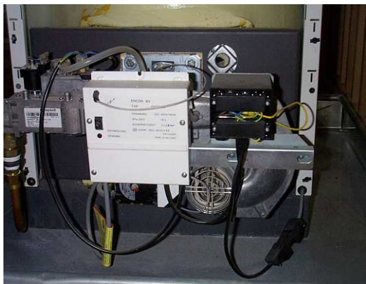
Figuur 7.23: gasgestookte verwarmingsketel met kleine ventilator (premixbrander)
