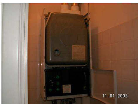
Figuur 7.21: gasgestookte verwarmingsketel met wandbevestiging (type C)
