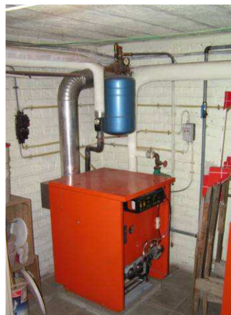
Figuur 7.16: atmosferische verwarmingsketel type B 11 met rookafvoer
