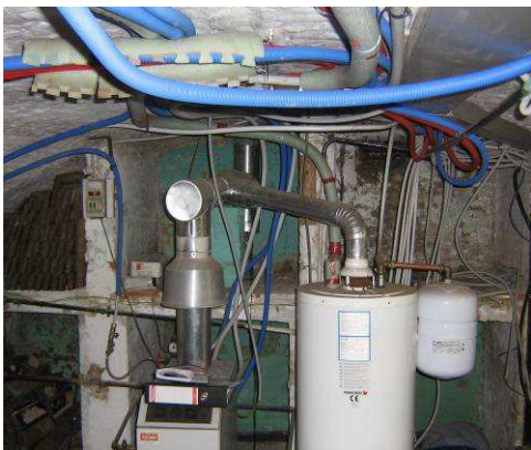
Figuur 1.6: oude ketel → NO x = 7 kg/jaar → daling van de emissie met 80%.
