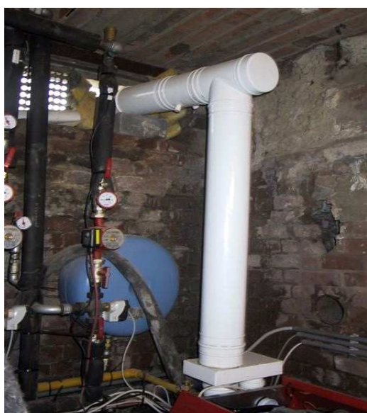
Figuur 7.19: gasgestookte condensatieketel met gesloten luchttoevoercircuit
