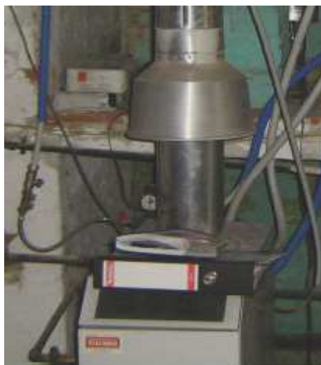
Figuur 7.14: verwarmingsketel met terugslagbeveiliging/ trekonderbreker
